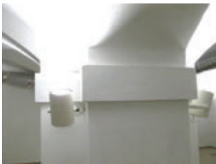
Alte Räume in neuem Glanz – S. 11
