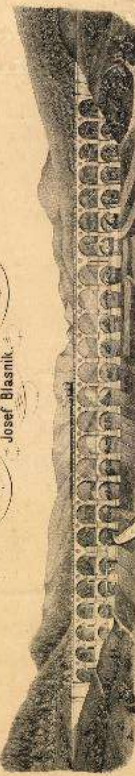
VILLACH BEI FRANZDORF. Länge 365'. Höhe 57'. Spurenbreite einer Spur der ersten Eisenbahn. Spurenbreite einer Spur der zweiten Eisenbahn 1 1/2'.
